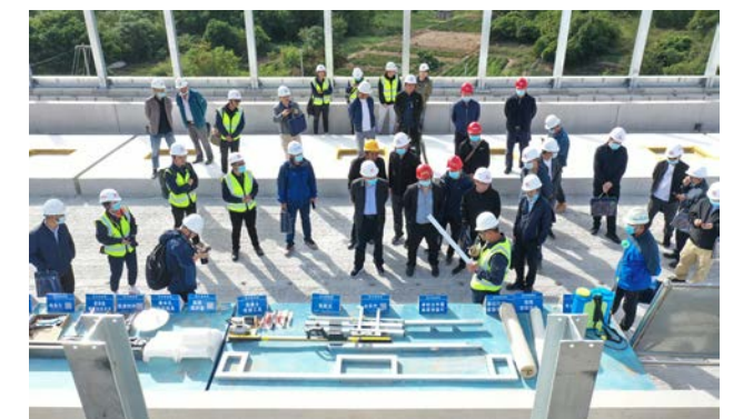
中铁四局福厦高铁迎来全线观摩
