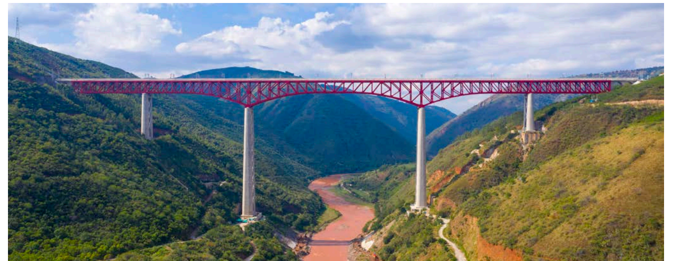
五公司参建的中老铁路元江特大桥
