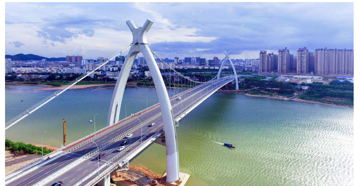
五公司承建的南宁英华大桥
